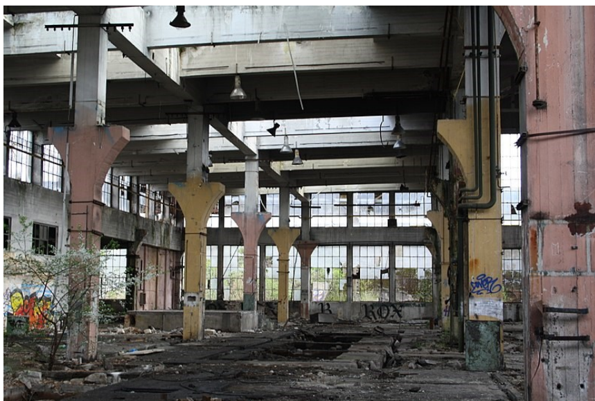
Ruiny továrny Praga ve Vysočanech, foto Leotard
