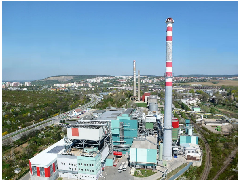
Spalovna odpadů Brno, foto Petr Opletal
