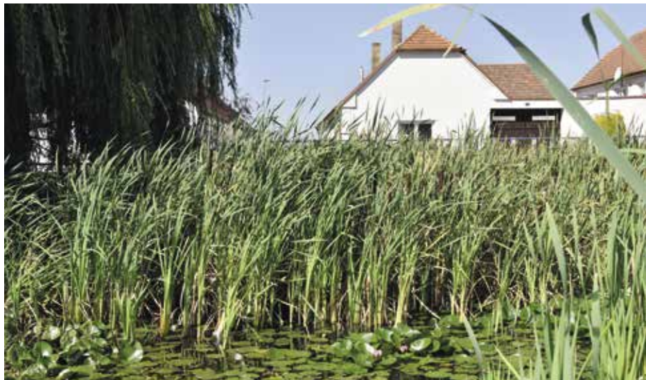
Virtská nádrž těsně před rekonstrukcí
