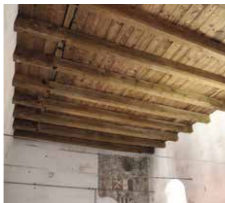
Strop Velkého rytířského sálu po rekonstrukci foto: archiv muzea
