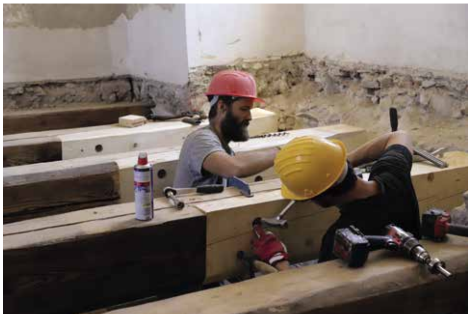
Protézování stropních trámů
